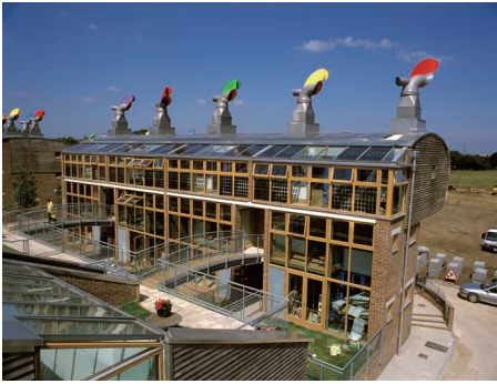
☉ 지붕에는 바람개비를 이용해 통풍 장치를 돌리고, 삼중 유리창을 설치해 실내의 보온 효과를 높이는 등 친환경적으로 설계된 영국의 베딩턴 제로 에너지 주택 단지의 모습
