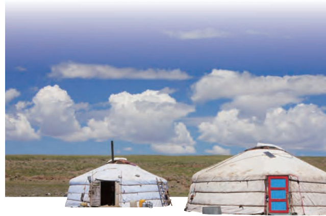
▲ 유목민의 전통 가옥 게르 계절에 따라 이동 생활을 한 유목민은 조립과 분해가 쉬운 게르에서 살았다. 게르는 나무로 뼈대를 세우고 그 위에 양털을 압축하여 가공한 천(펠트)을 덮어 만든 이동식 가옥이다.
